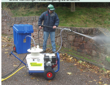
Sandstrahlreinigung
