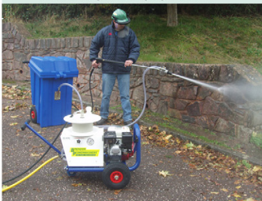
Sandstrahlreinigung
